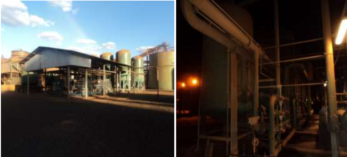
Figura 3: Estação de Tratamento de Água e filtros floco decantador. Fonte: Oliveira (2012).
