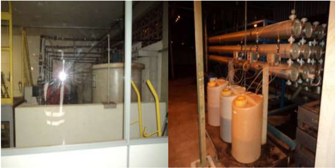
Figura 4: reservatório de 1.000.000 l 3 e filtros de água da ETA. Fonte: Oliveira (2012).
